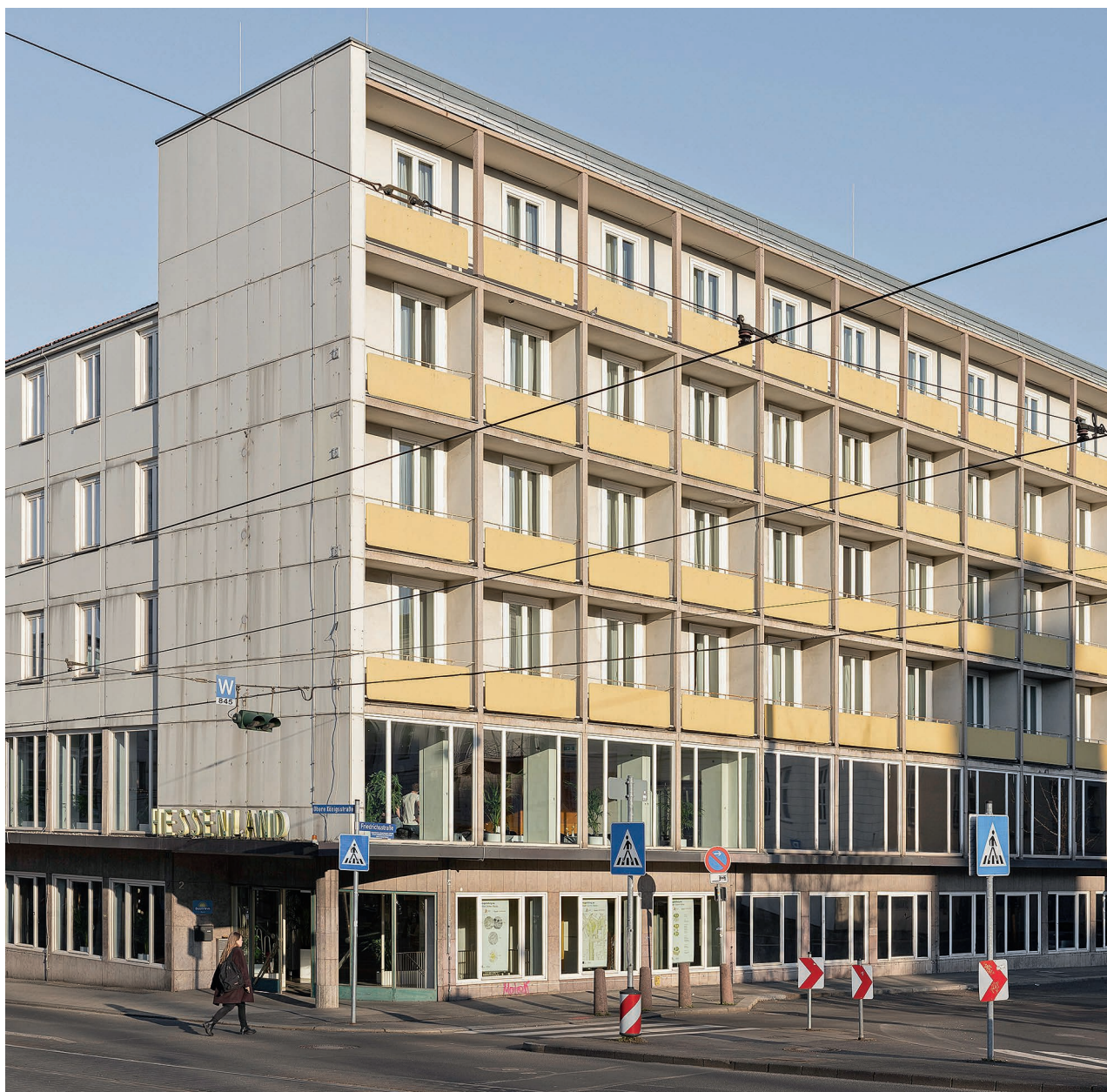
Hotel Hessenland, Außenansicht, Kassel, 2022
